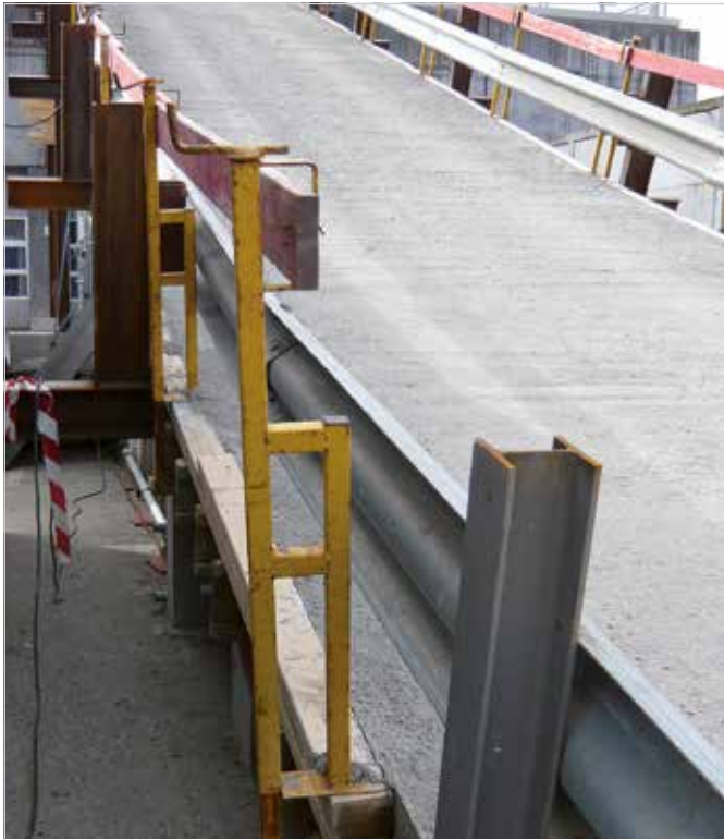
Absicherung einer Baustellenzufahrt mit Geländerhalter TITAN H
