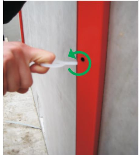
Vor dem Betonieren den festen und korrekten Sitz der Schiene überprüfen!
