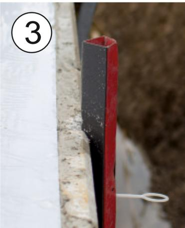
◀ FLUXX Abschalschiene in der Fuge arretieren
